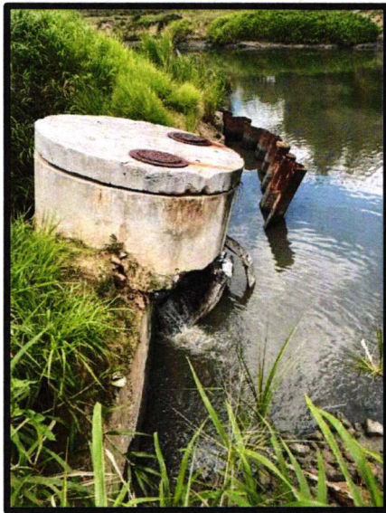
Figura 2. Registro Sanitario Colapsado Figura 3. Desplazamiento de Tablestaca
