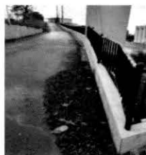
Construcción de muro de contención
