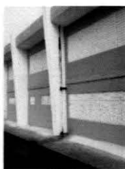
Construcción de columnas
