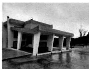
Construcción de pórtico
