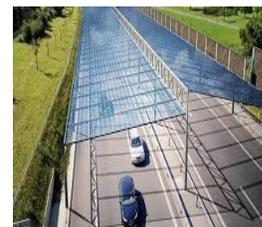
Ejemplos de paneles solares instalados en autopistas a manera de garaje, en las medianas y en los extremos.
