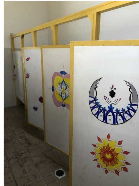
Ilustración 32. Reemplazar división de baños por polilla
