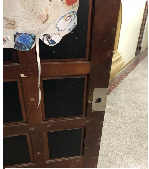
Ilustración 10. Reemplazar o instalar cerraduras
