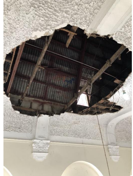
Ilustración 26. Techo de pasillo del tercer piso
