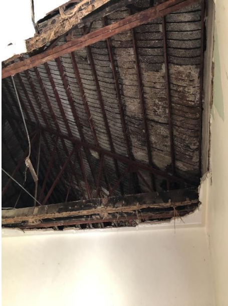
Ilustración 25. Techo del salón 312
