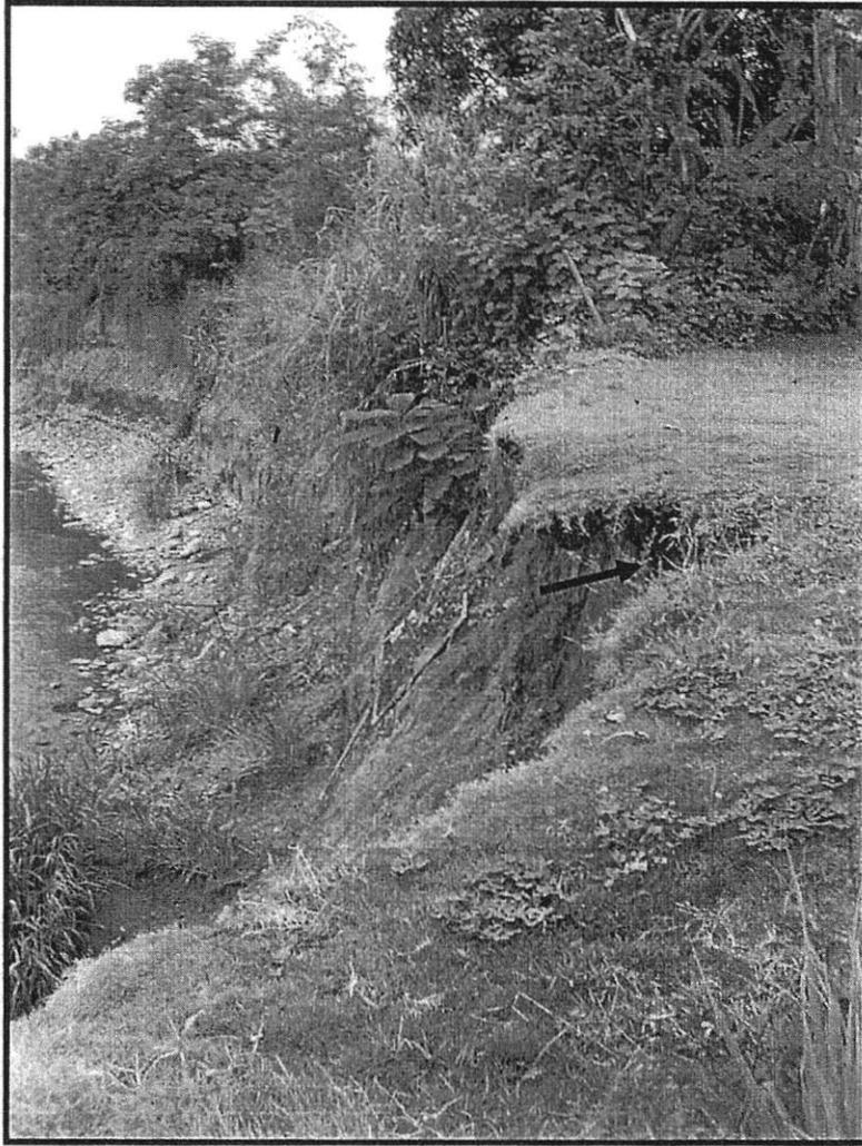
Figura 2. Corte y movimiento de masa cerca de la zona del derrumbe principal. El corte de terreno y movimiento es mayor en la zona concava del meandro. Esto podría estar relacionado con la concentración de velocidad del flujo del río. Observe indicaciones de terreno socavado en la zona.
