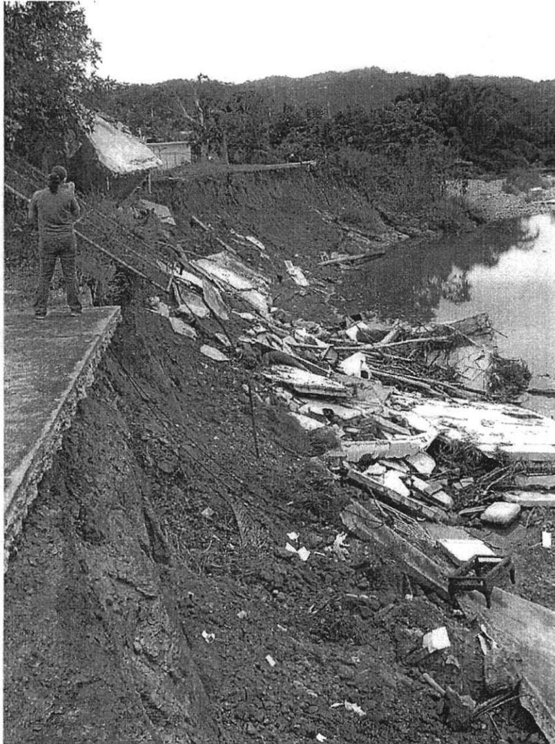
Figura 3. Vista general del derrumbe ocurrido en la Primera sección de Villa del Rey, Caguas. Observe el corte vertical del movimiento de masa, especialmente la magnitud del movimiento en la forma concava del meandro. Se puede observar que la sección alejada del meandro aparentemente no presenta corte de terreno.
