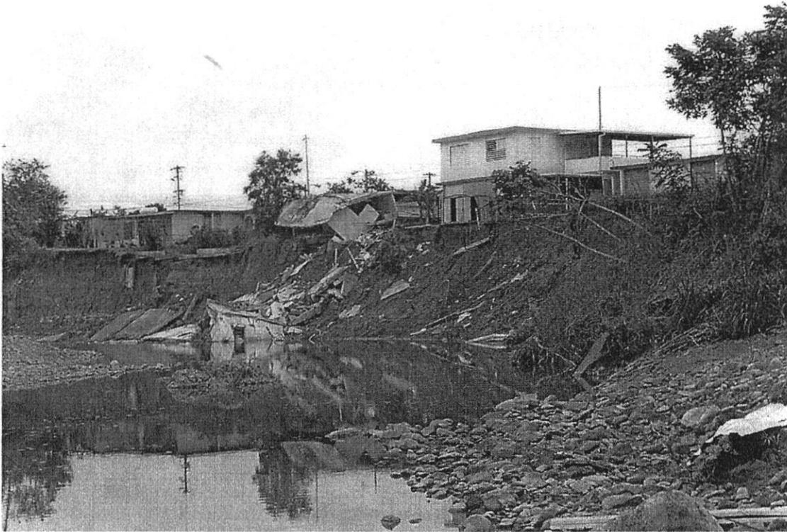
Figura 5. Vista de la zona del derrumbe. El corte ocurre en la zona cóncava del meandro.
