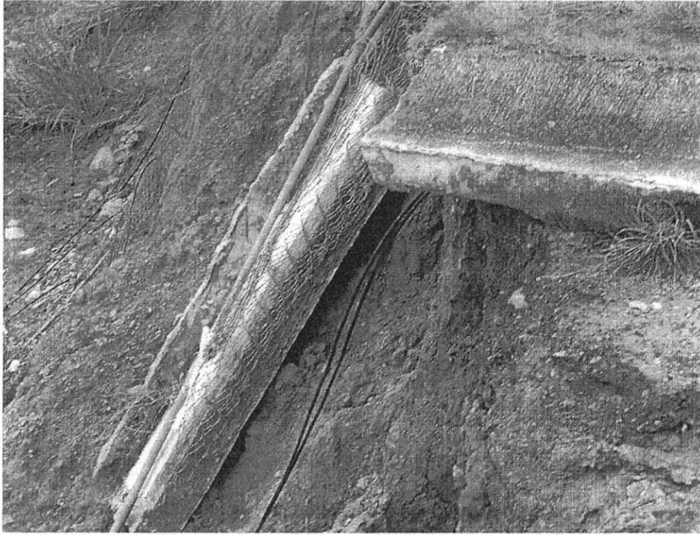
Figura 15. Vista del terreno expuesto después del derrumbe. Vea grava expuesta en la capa del terreno.
