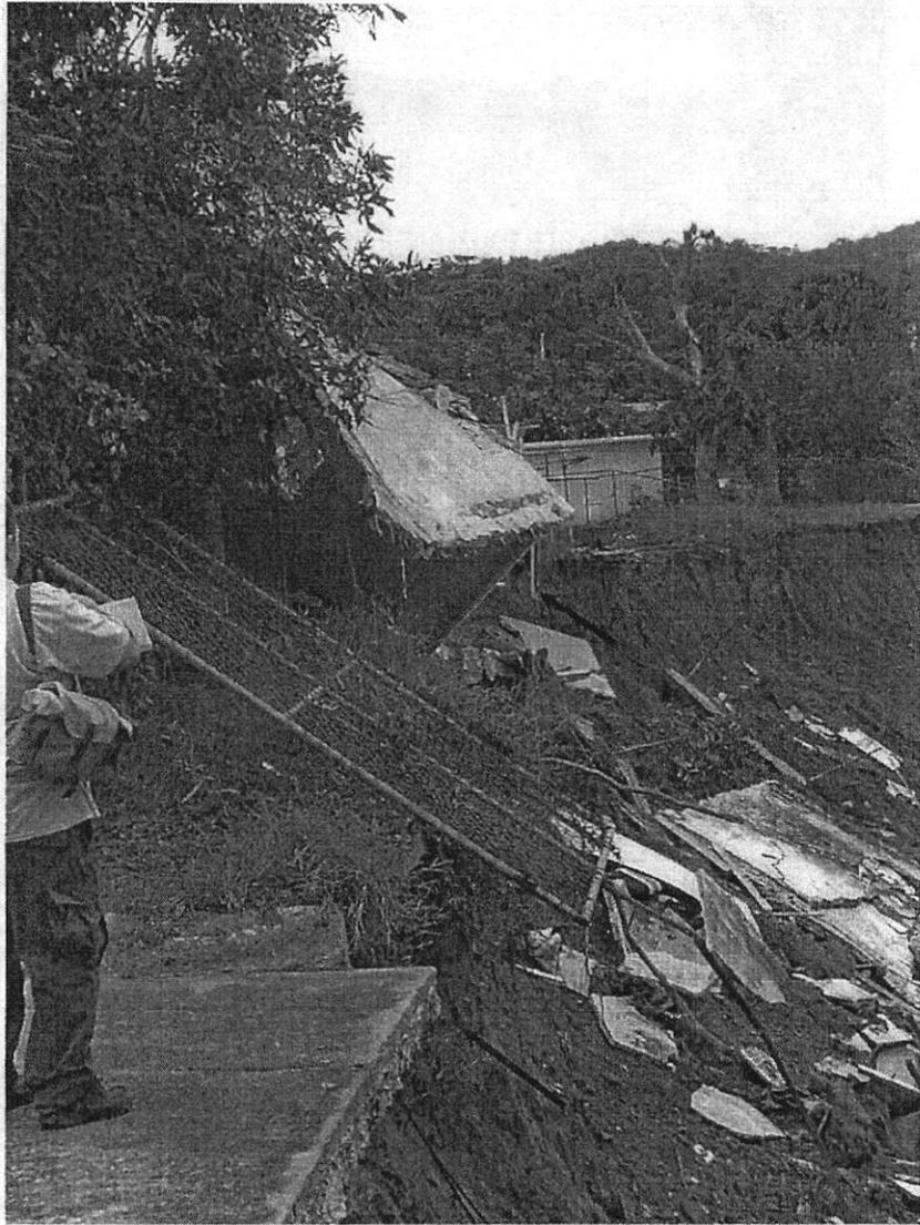
Figura 4. Vista del corte de movimiento de masa en el terreno colindante de la urbanización con el meandro del río Turabo. Observe áreas de terreno socavado.
