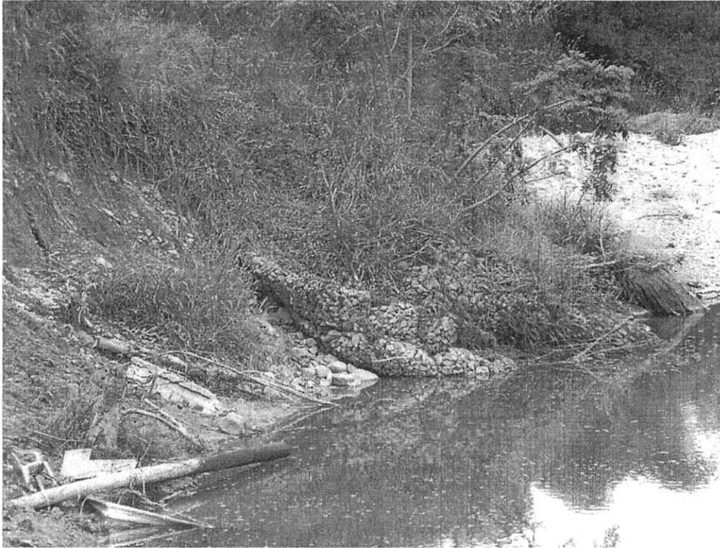
Figura 11. Area de gaviones arrancados. Se observa zona del terreno erosionada.
