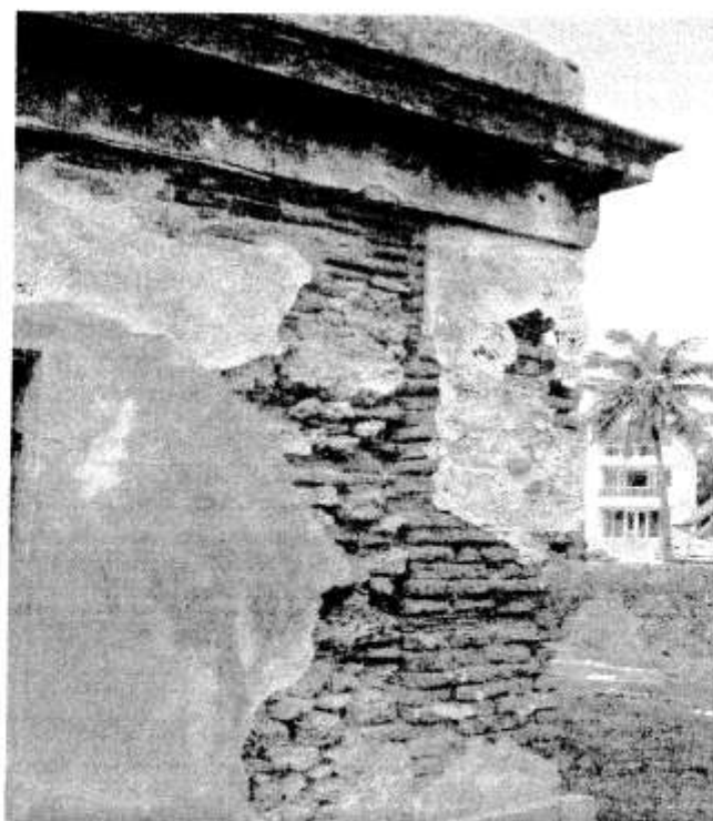
CASA DE OFICIALES ESQUINA NOROESTE
