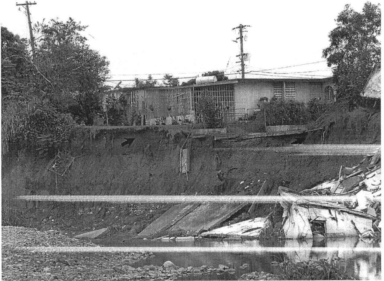
Figura 8. Vista del corte del terreno, vea zonas socavadas.
