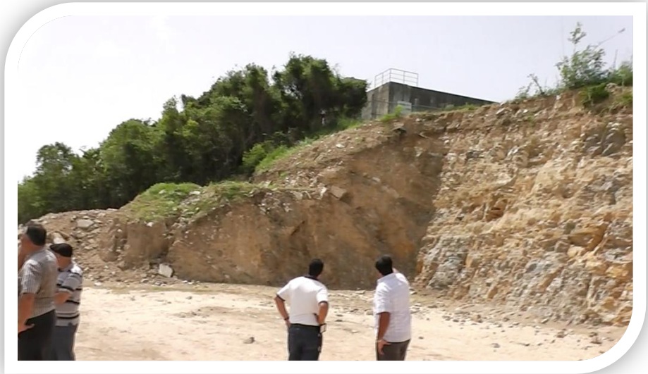
Figura 2. Movimiento de tierra realizado
