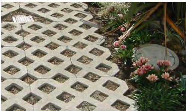
Unidad en concreto prefabricado.
